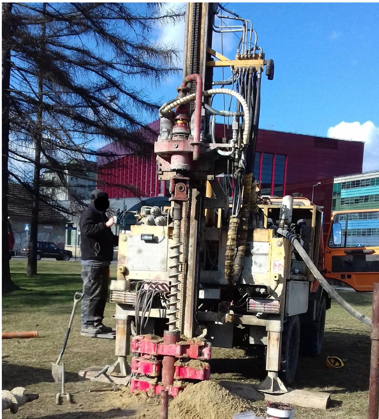
Fotografia 1 Wiercenie świdrem ślimakowym w rurach osłonowych, otwór OW-78
