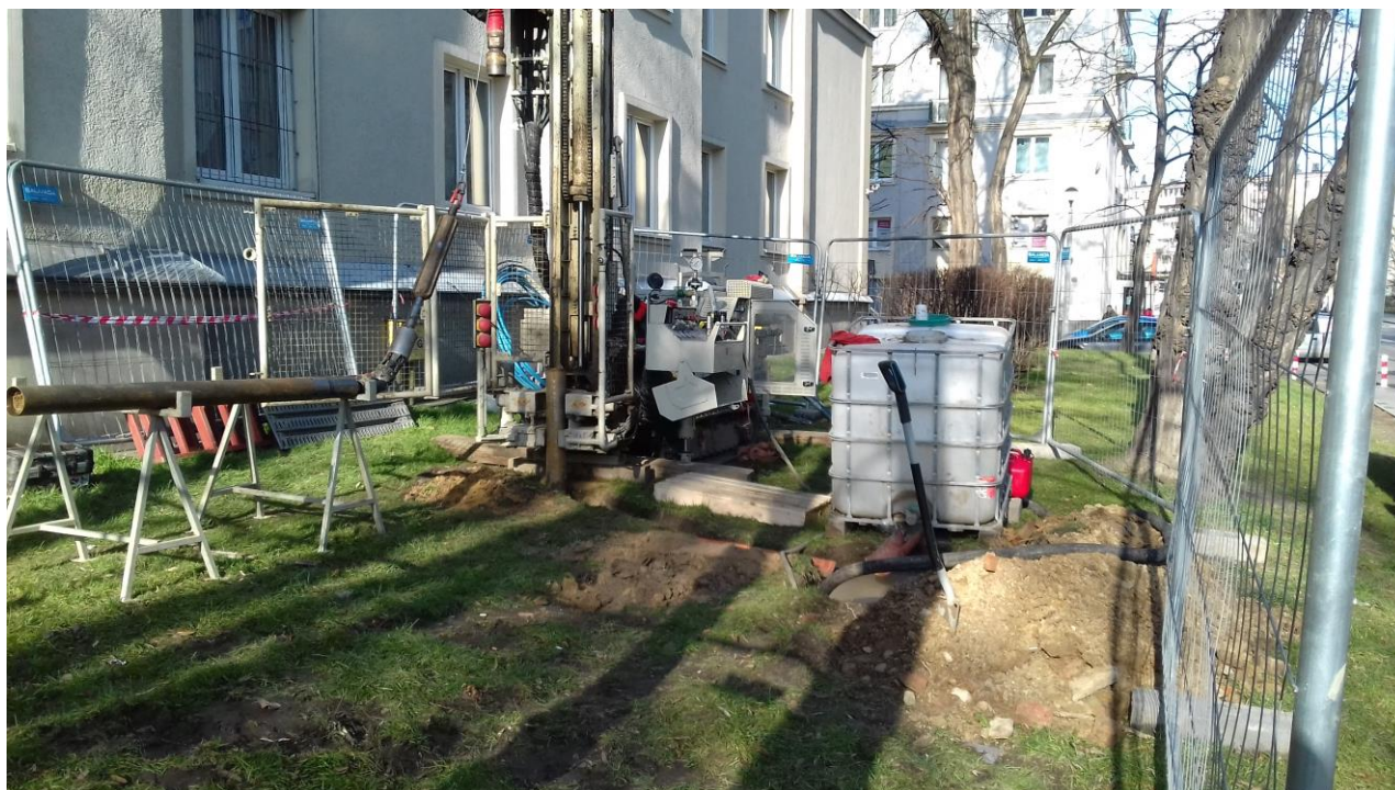
Fotografia 2 Wiercenie rdzeniowane w rurach osłonowych, otwór OW-41.
